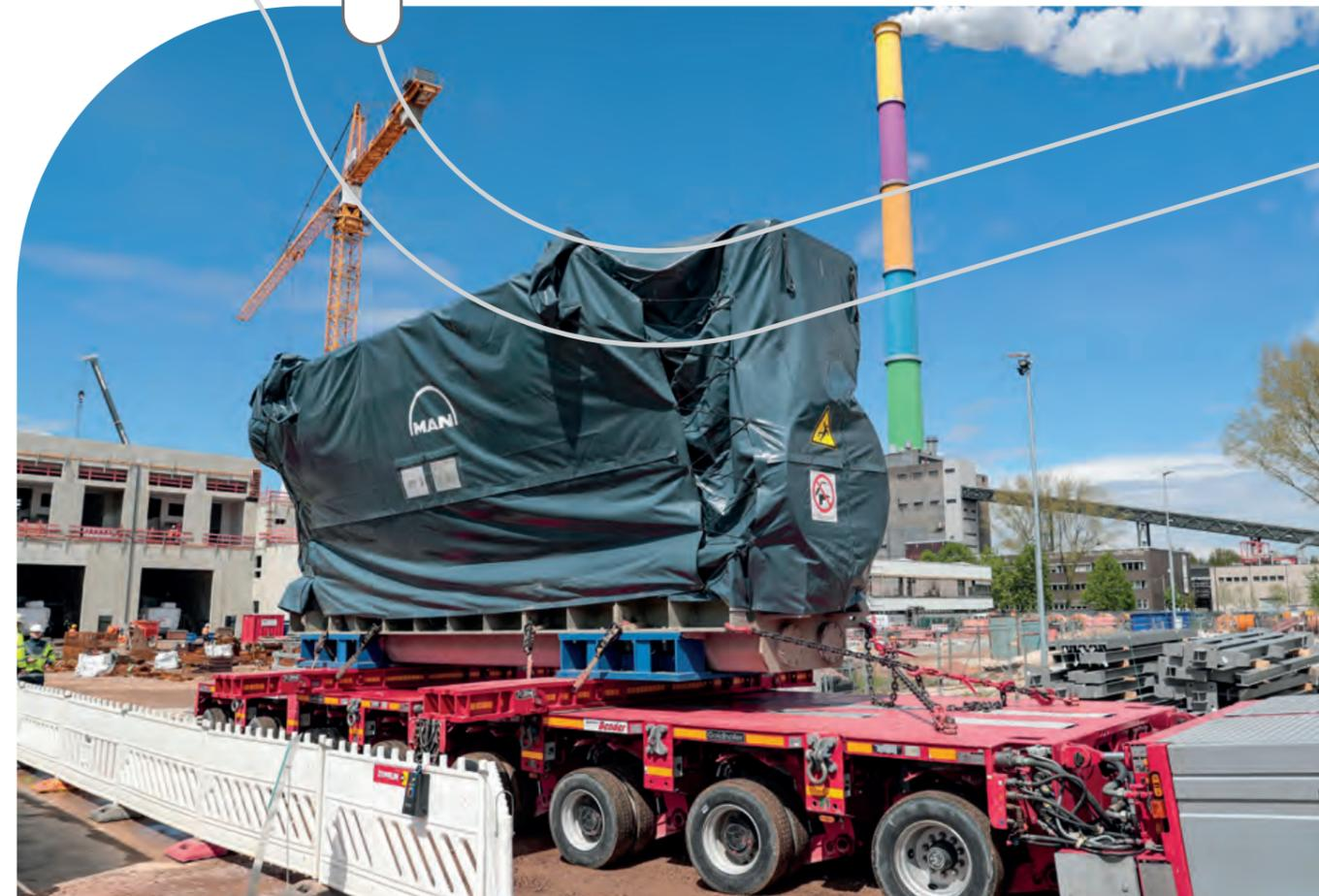
Herzstück der neuen Anlagen sind 12 riesige Motorenmodule bestehend aus Motor, Generator und Turbolader. Hier sieht man die Anlieferung des letzten Motors im Mai 2021.
